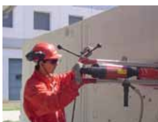
Travail sur colonne : les deux mains sur le volant
