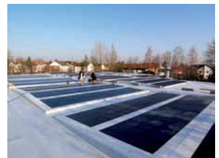
Toit de la cantine du site de Kaufering (Allemagne)
