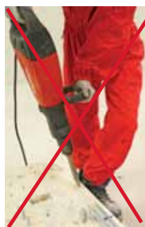
En position vers le sol, toujours buriner vers l'extérieur
