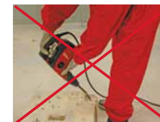
En position vers le sol, toujours buriner vers l'extérieur
