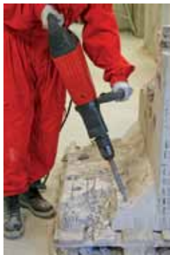
En burinage en bas de mur, les mains sur chacune des poignées
