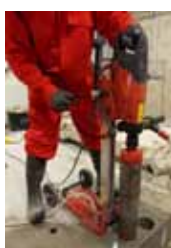
Travail à main : Les deux mains sur les poignées, en prenant soin de régler la poignée latérale.
