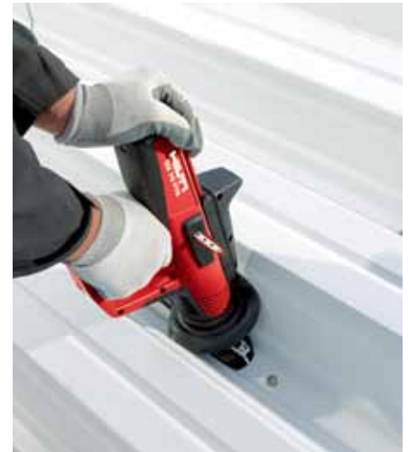
Fixation avec le DX 76-PTR
