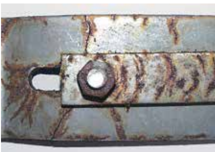
Fig. 8: Spanningscorrosie in een klamp gemaakt van 1.4301 materiaal (A2, 304), na vier jaar gebruik in een overdekt zwembad
