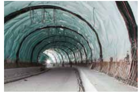
Fig. 26: Wegtunnels vormen een erg corrosieve omgeving (dooizout en uitlaatgassen van het verkeer).
