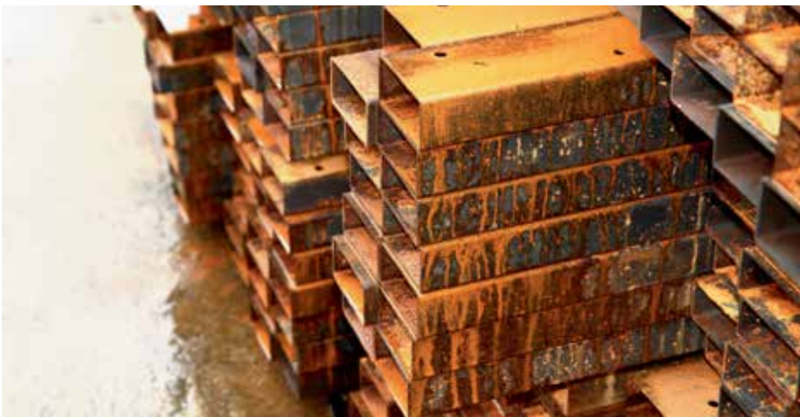
Fig. 4: Corrosie van stalen onderdelen
