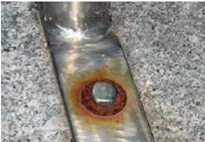
Fig. 12: Dit is een typisch geval van contactcorrosie. Verzinkt koolstofstaal (ring) en roestvrij staal (schroef en onderdeel) werden samen gebruikt. Het oppervlak van het edelste metaal – het roestvrij staal – is groter, met sterke corrosie van de ring tot gevolg
