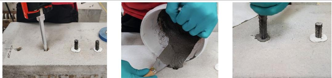
Figure 4-4 : Installation du HIT-FP 700 R et des coulis de ciment génériques.
