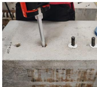
Figure 4-2 : Mise en place d'une barre 700 R d'armature
