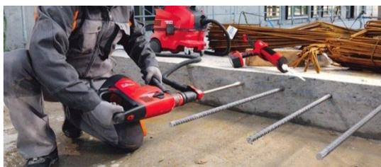
Figure 4-5 : Installation de la technologie SafeSet
